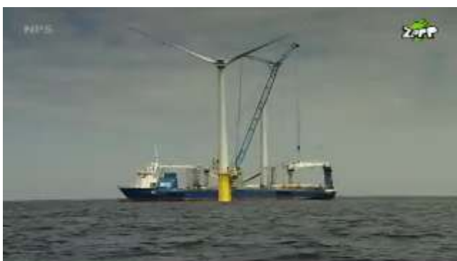
Daarna wordt de windmolen geplaatst .
