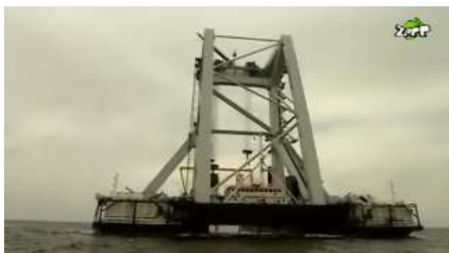
Op het water schommelt alles.
