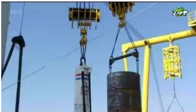
De paal wordt de grond in geheid.
