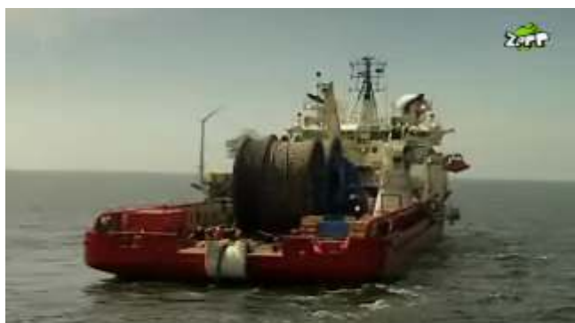
De kabels komen op de bodem. Dan gaat er nog zand over.
